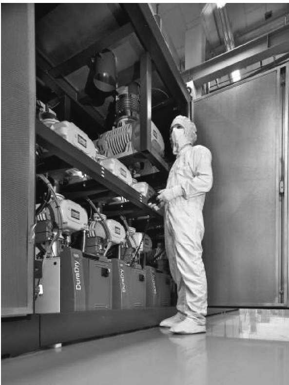
圖 9. 用於 PECVD 製程的 DURADRY/RUVAC 幫浦系統。
