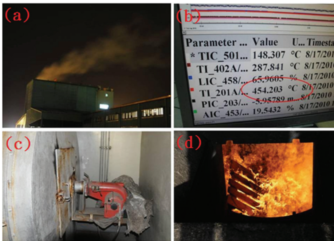
圖 8. 稽查人員現場稽查之違法事證 (a) 濃濃白煙排放、(b) 未達操作溫度即處理高含氯之廢液、(c) 防治設備未開啟、(d) 恣意燃燒廢棄物等。
